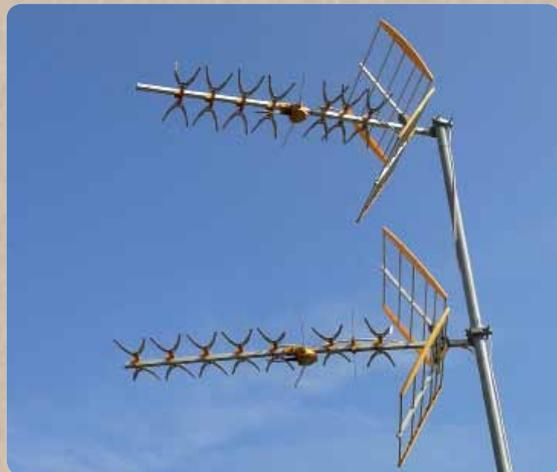
Nous ne savons pas si l'intension est d'augmenter le rapport Av/Ar de l'antenne, ou de profiter du signal réfléchi par le réflecteur pour renforcer le signal capté par le dipôle. Nous ne savons pas si le fait de garder les éléments directeurs non relevés (comme dans l'emballage) a un lien avec la polarisation reçue (H/V). De toute évidence il y a un gros effort d'imagination, mais pas forcément d'efficacité
