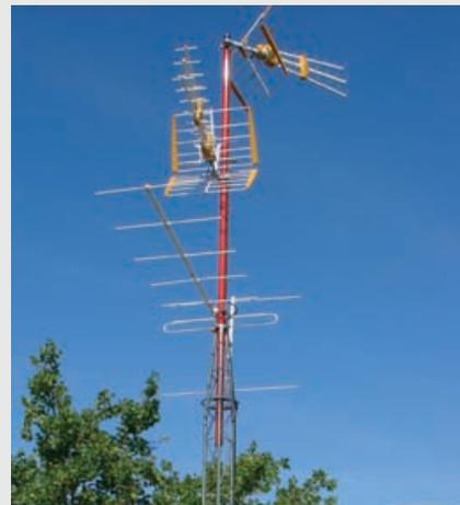
A recepção terrestre é feita por 1 antena (Ref. 1191) para o canal 1 (VHF), 2 antenas DAT 45 (Ref. 1095) para os restantes 3 canais portugueses e os 4 canais espanhóis, e uma antena (Ref.1201) para FM. A recepção de satélite está a cargo de 1 antena de 1100mm (Ref. 7572) e um LNB colectivo (Ref. 7477) para o serviço TV Cabo.
