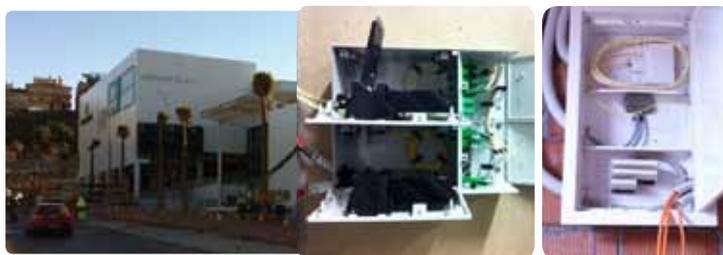
Elle se compose de 6 transmodulateurs DVB-S2-COFDM, 4 processeurs, 2 amplificateurs BIS, 2 émetteurs optiques et 2 répartiteurs optiques.
