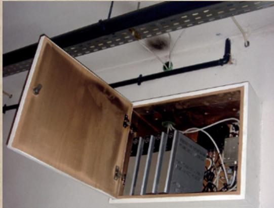
La canalización para la entrada de cables se ha convertido en una chimenea de salida de humos y calor.
