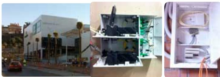
Está compuesto por 6 transmoduladores DVB-S2 - COFDM, 4 procesadores de canal, 2 centrales de FI, 2 emisores ópticos y 2 repartidores ópticos.
