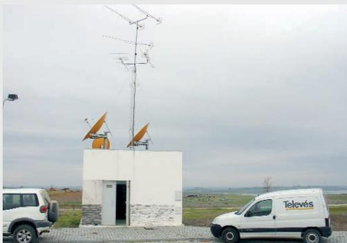
A instalação da rede de CATV da Nova Aldeia da Luz passou a ter disponível desde final do mês de Janeiro sinais digitais modulados em QAM. Partindo da modularidade em rack do equipamento de cabeça em funcionamento contínuo desde de Junho de 2002 esta evolui sem nenhum tipo de restrições para a transmodulação do pacote digital DTH da TV Cabo.
