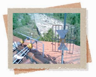
O recurso à utilização de materiais recicláveis para criar um novo utensílio como uma Antena para canais terrestres é de aplaudir. Esta antena que "captamos" em Trás-os-Montes construída com recurso a um elemento reflector e a uma caixa de ligações (com qualidade superior a muitas encontradas no mercado) de uma antiga antena rematando com um dipolo estilo "Papillon" posicionado na vertical ganharia com certeza o prémio de originalidade.
