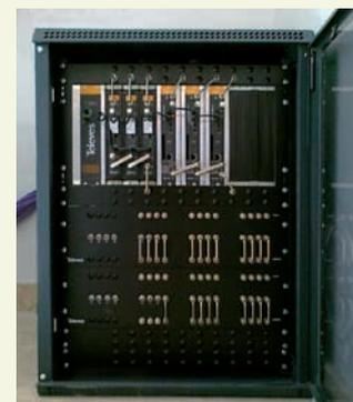
pretender aceder a conteúdos por subscrição. A amplificação é realizada por 2 módulos Monocanal T03, um para a Televisão Digital Terrestre e o outro para a amplificação dos canais disponibilizados pelos TOX.
