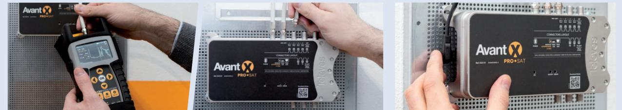
**3. RIPETERE** l'operazione di misurazione e di collegamento per ogni cavo di antenna VHF, UHF e FM
